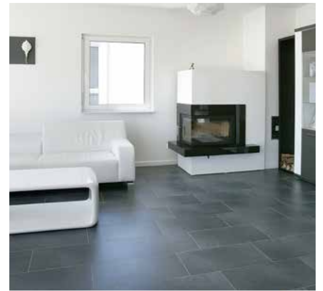
Fußbodenheizung als Standardausstattung.
