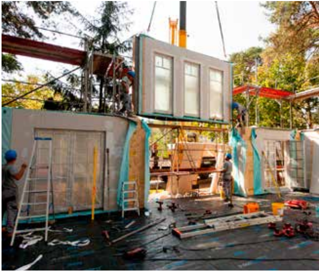
Anschließend wird das Obergeschoss aufgesetzt.
