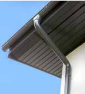
Die Unterseite des Dachüberstandes kann farbig oder in weiß (Standard) ausgeführt werden.
