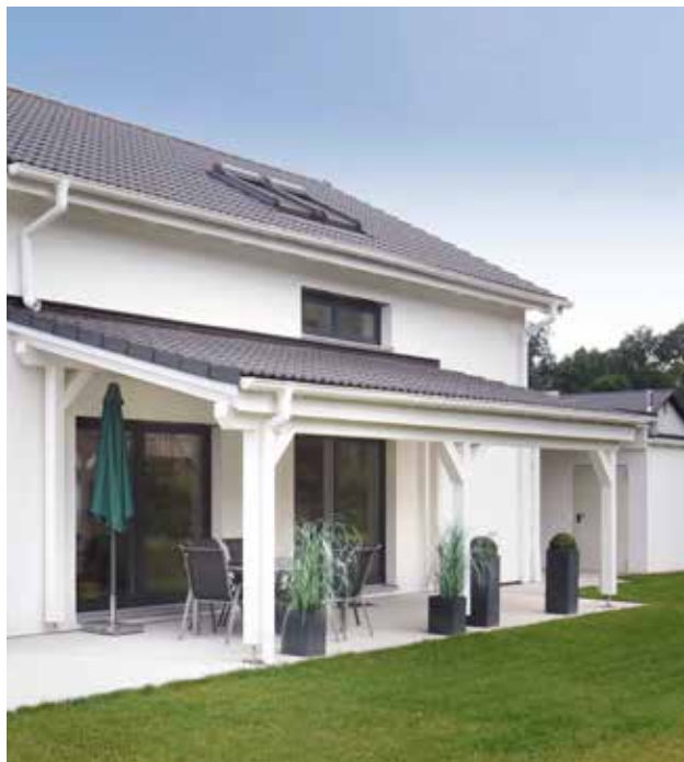
Solides Dach über der Terrasse
