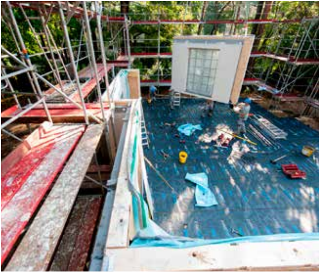
...und das Erdgeschoss auf das Fundament montiert.
