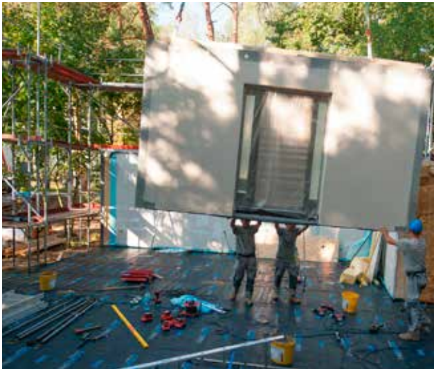
... auf LKW zum Bauplatz transportiert...
