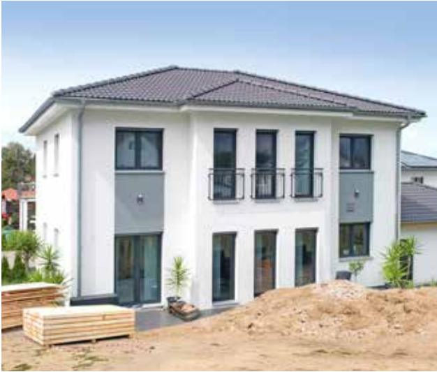
Nach ca. 12 Wochen ist die Villa fertig...
