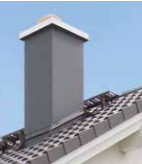
Der Schornstein wird in der Dachfarbe gestrichen***
